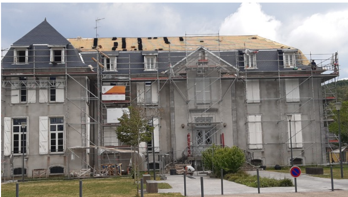
Figure 1: Château de Chéraute en travaux. juin 2022
